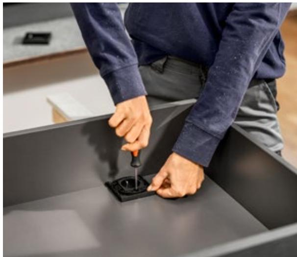
① Para montar el enchufe, basta con taladrar el fondo del cajón.
